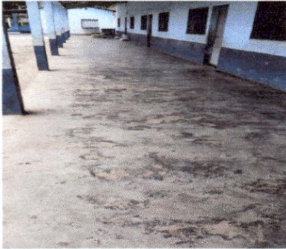
Foto 1: Sustitución de piso
