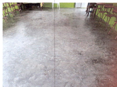
Foto 6: Sustitución de piso en aula.
