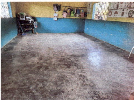
Foto 5: Sustitución de piso en aula.
